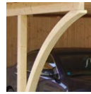
Arcos de madera laminada
